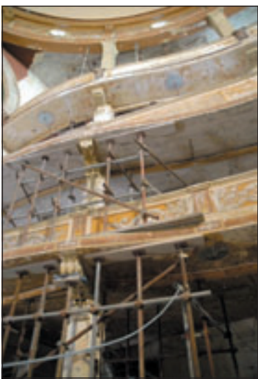
I lavori di ristrutturazione del teatro Apollo
